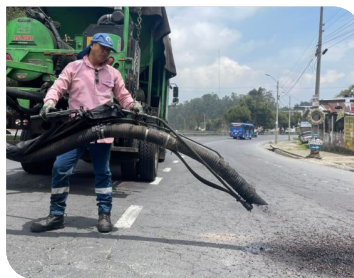
2. APLICA el riego de liga en la superficie a reparar.
