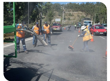
3. APLICA la mezcla de agregados y emulsión.
